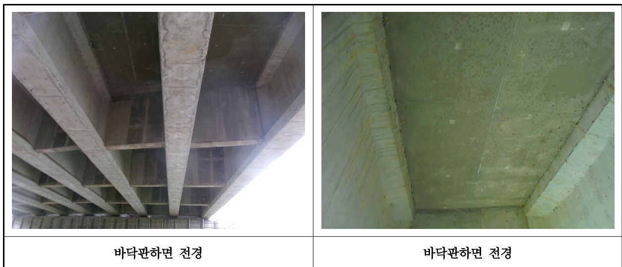
【사진 1.3.2】 바닥판하면 전경
