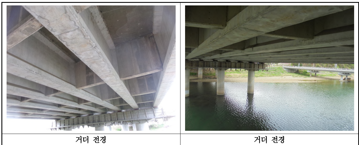
【사진 1.3.4】 거더 전경
