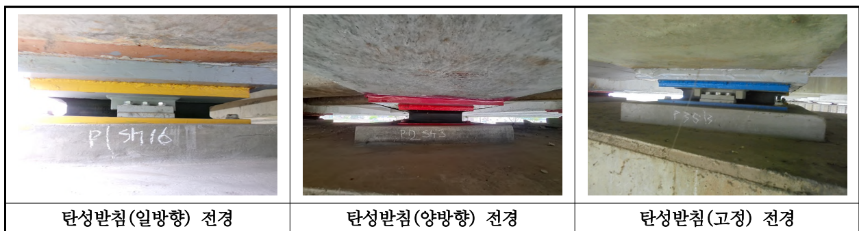
【사진 1.3.12】 교량받침 전경
