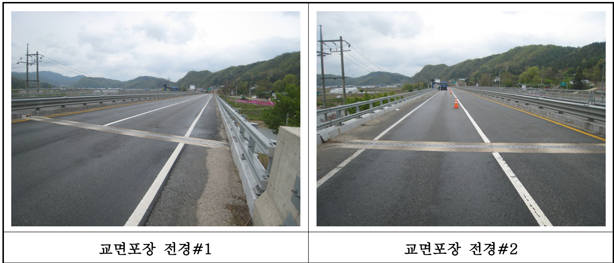
【사진 1.3.19】 교면포장 전경
