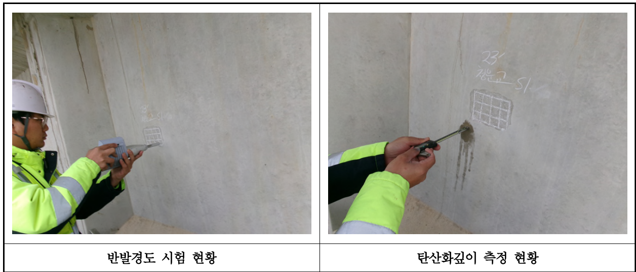
【사진 1.4.1】 콘크리트 내구성조사 현황
