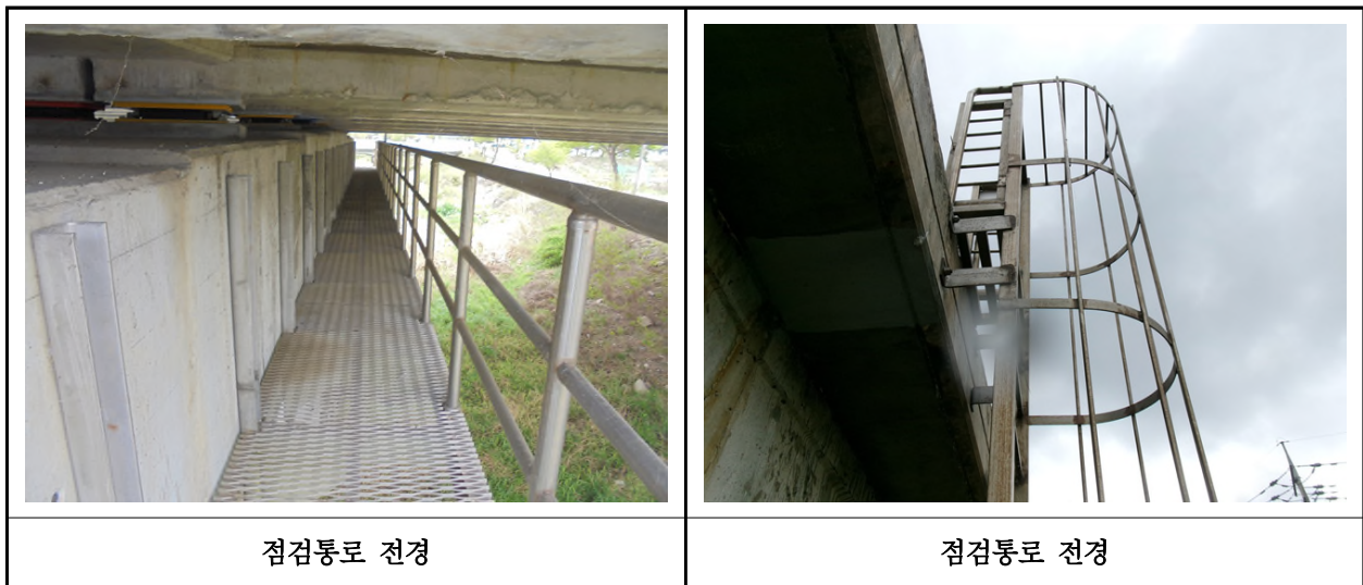
【사진 1.3.25】 교량 점검시설 전경
