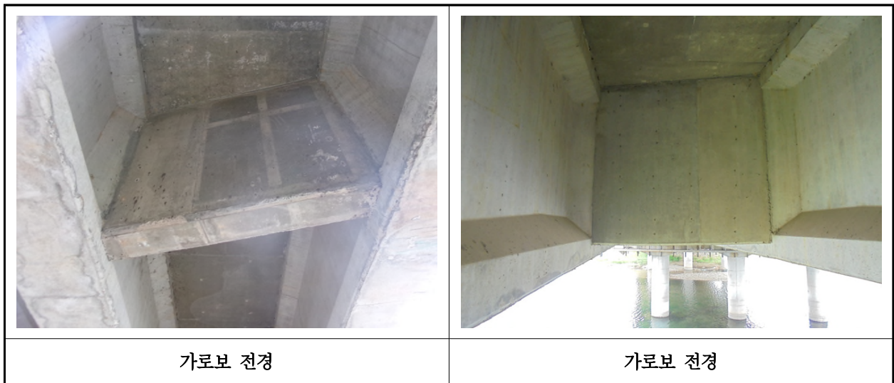
【사진 1.3.6】 가로보 전경
