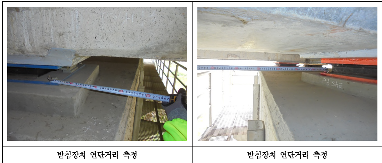
【사진 1.3.14】 교량받침장치 연단거리측정
